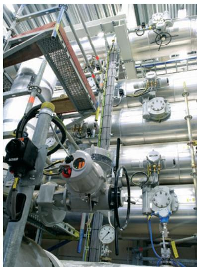
Attuatori e riduttori Rotork installati in un impianto industriale
